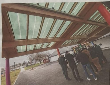
Le premier site de panneaux photovoltaïques organiques 100 % made in France a été inauguré à l'école de Lagos. O.L.D.
